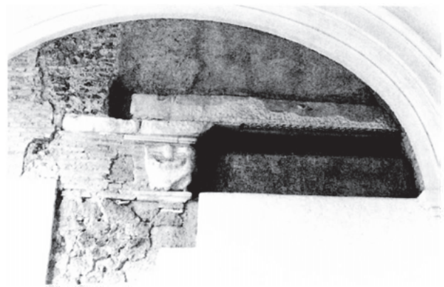
90. Rom, S. Bartolomeo all'Isola. Nordwand der Vorhalle. Aus Spolien zusammengesetzte Architravstruktur (Foto Claussen)
